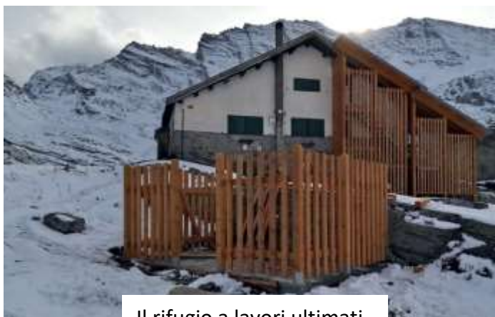
Il rifugio a lavori ultimati
